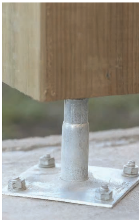
PIEDS DE POTEAU
